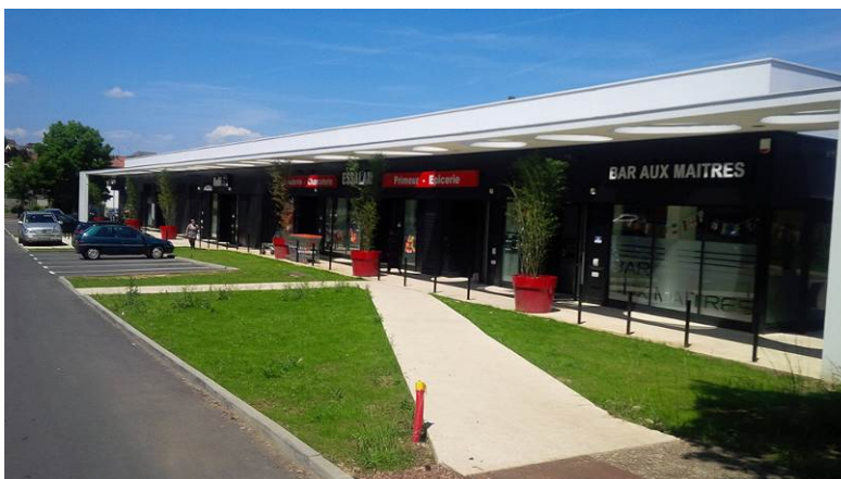
Espace commercial Les Bleuets à Mont Saint-Martin (54) Barrand+Corpelet Architectures © Epareca
