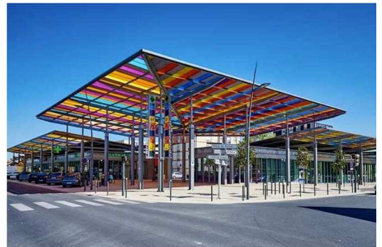
Le centre commercial Palissy à la Chapelle-Saint-Luc (10) 1 071 m 2 , 9 commerces
